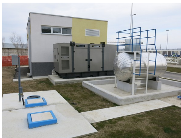
Slika 29. Trafostanica sa dizel agregatom i rezervoarom za sedmodnevnu potrošnju goriva
