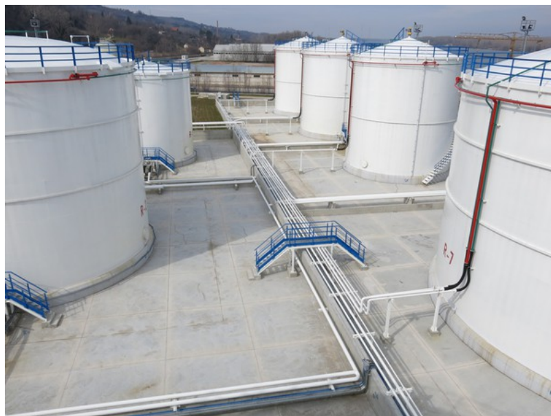
Slika 15. Armiranobetonske tankvane oko rezervoara
