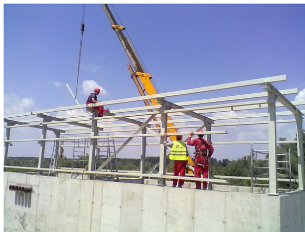
Slika 18. Izgradnja pumpne stanice za pražnjenje cevovoda
