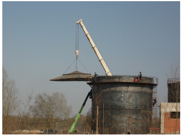
Slika 10. Krov konusnog tipa
