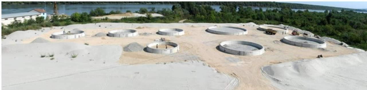
Slika 2. Temelji rezervoara za naftne derivate
