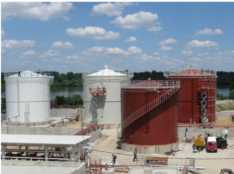
Slika 11. Antikorozivna zaštita rezervoara
