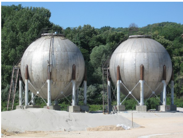
Slika 13. Postojeće stanje sfernih rezervoara
