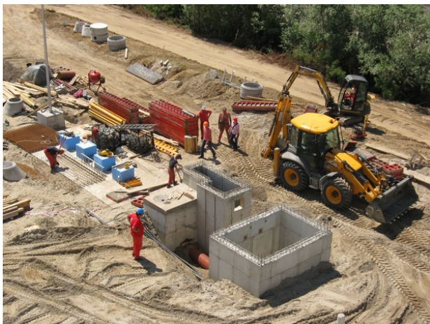
Slika 27. Izgradnja prepumpne stanice
