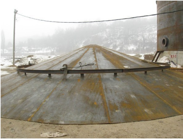
Slika 10. Krov konusnog tipa
