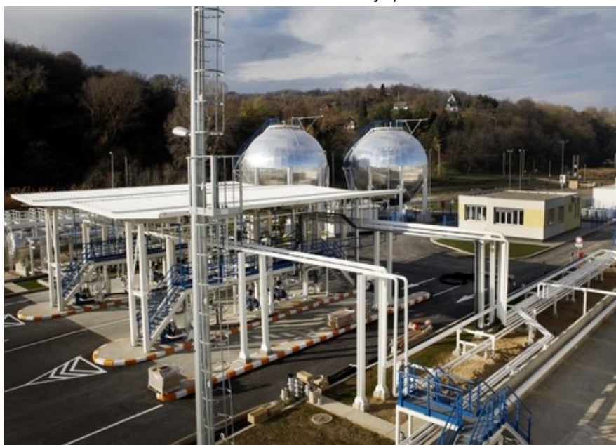
Slika 12.. Čelična konstrukcija pretakališta
