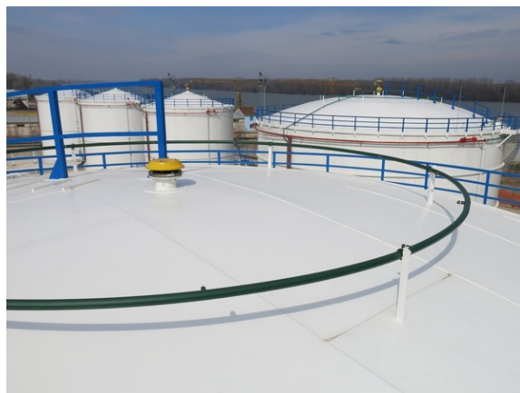
Slika 23. Mlaznice na krovu rezervoara
