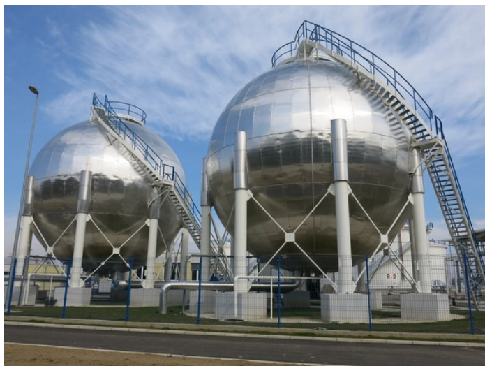
Slika 14. Sferni rezervoari posle rekonstrukcije
