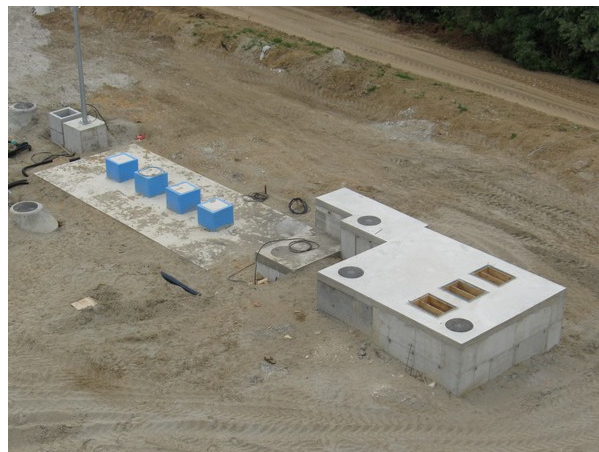
Slika 28. Izgrađena prepumpna stanica
