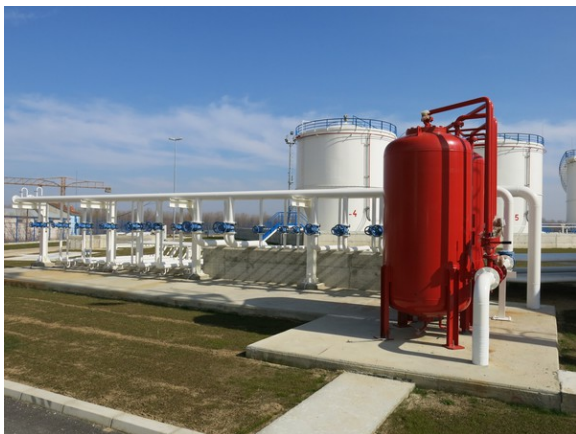
Slika 22. Dozator pene pod pritiskom
