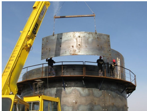
Slika 7. Montaža limova omotača
