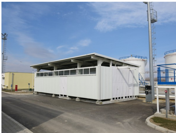
Slika 17. Tehnološka pumpna stanica
